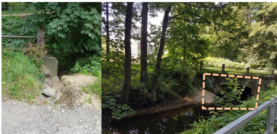
61.,62.att. Izskalojums un caurteka zem Brūkļu ielas [Avots: autora uzņemtas fotogrāfijas].
