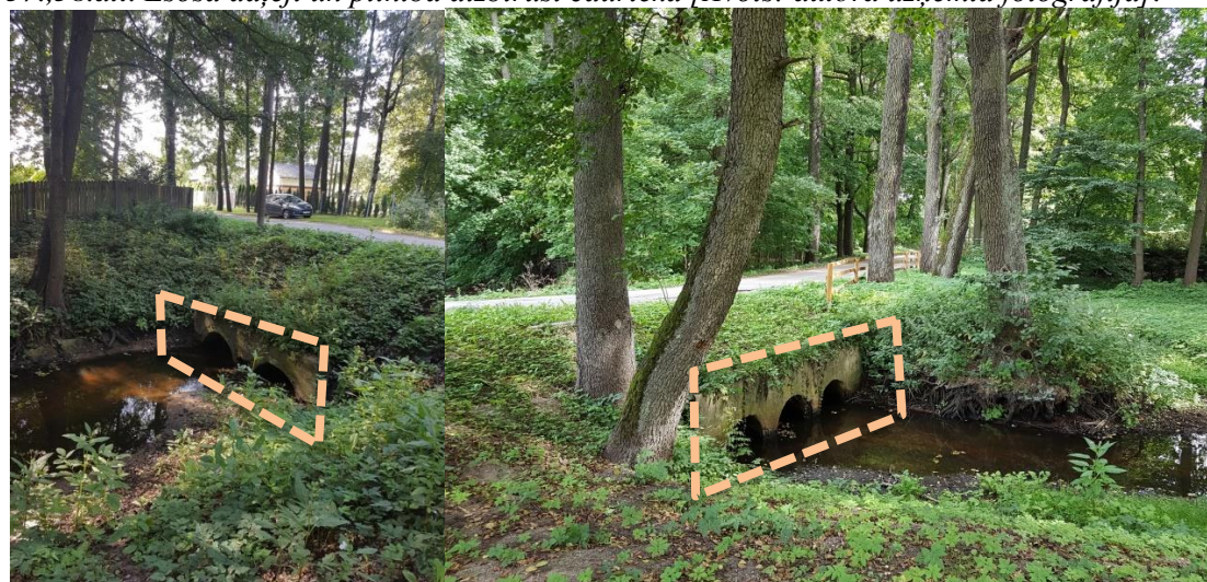
59.,60.att. Caurtekas zem Dauguļu un Codes ielas [Avots: autora uzņemtas fotogrāfijas].
