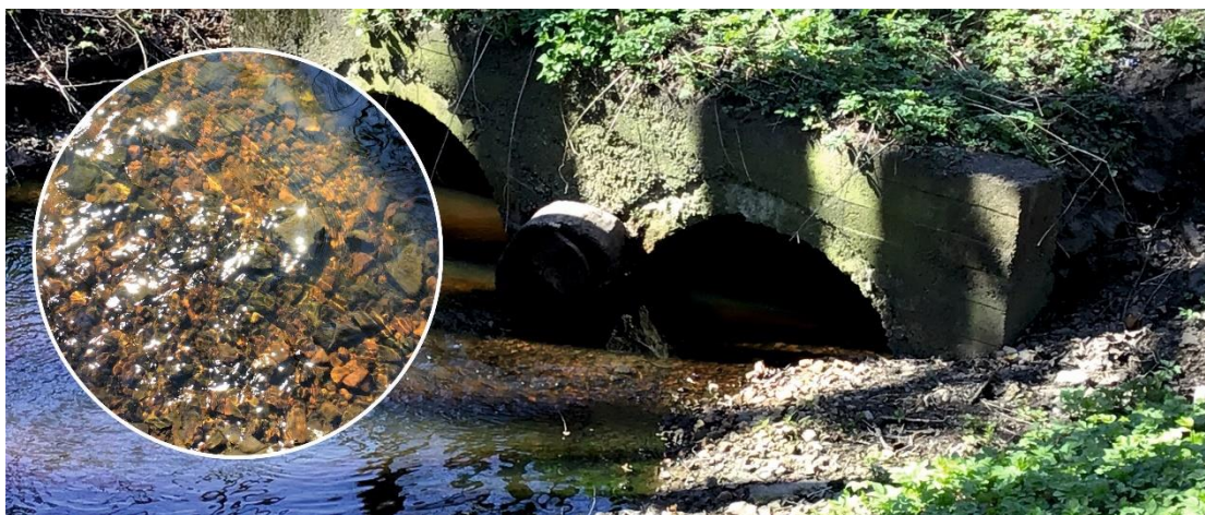
41.att. Ceļa šķērsojuma vietā gultni veido caurtekas stiprināšanai izmantotais akmens šķembu materiāls [Avots: L. Urtānes fotogrāfijas].
