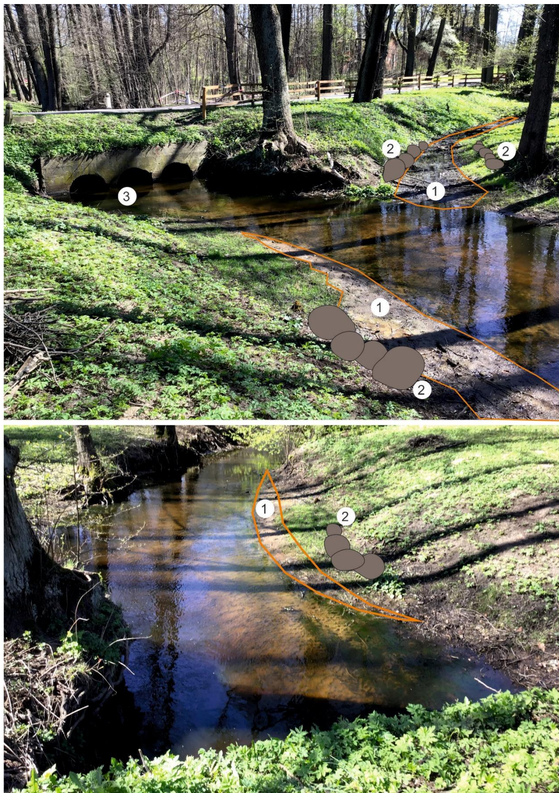
148.att. Mārupītes gultnes dažādošana posmā augšpus Codes ielas šķērsojuma. 1- norok piesērējušo centrālo daļu; 2- krastu nostiprina ar akmeņu rindu; 3- caurteku atbrīvo no aizsērējuma [Avots: L. Urtānes fotogrāfijas, A.V.Urtāna zīm.].
