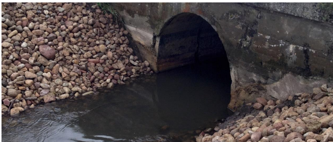
86.att. Krastu stiprināšanai izmantotais nesaistītu akmeņu materiāls krasta–ūdens saskares zonā kļūst par akmeņaino dzīvotņu apdzīvojošo ūdens organismu uzturēšanās un zivju barošanās vietām [Avots: L. Urtānes fotogrāfija].
