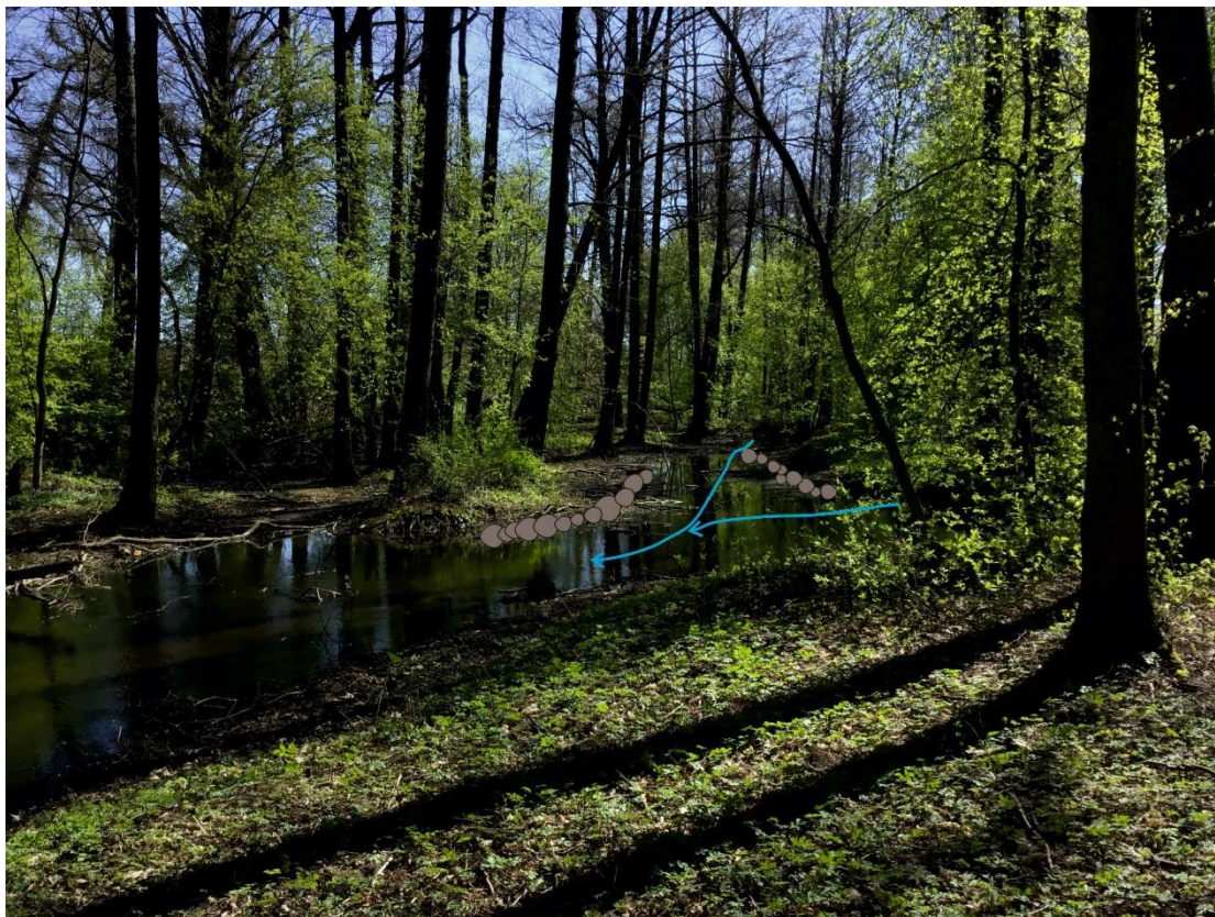
150.att. Gultnes dažādošana Bierīņgrāvja un Mārupītes satekas vietā. Akmeņi izvietoti tā, lai sašaurinātu Bierīņgrāvja gultni un straumi novitzītu no melnalkšņu saknēm [Avots: L. Urtānes fotogrāfijas, A.V.Urtāna zīm.]
